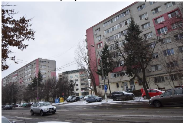
Vedere acces proprietate subiect și exterior imobil bloc CF 251445-C1-U69
