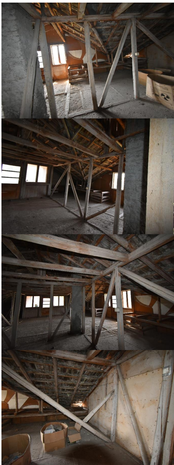
Extindere C1 neintabulată – interior și exterior:
