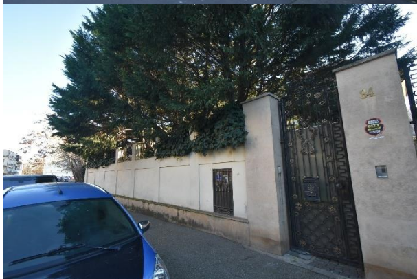
Vedere Exterior C1:
