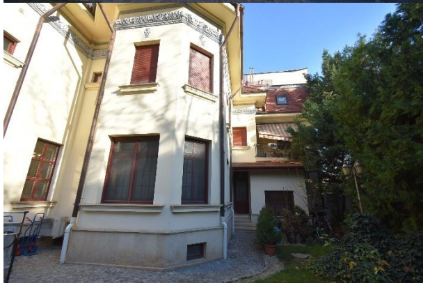
Vedere Subsol 2 C1:
