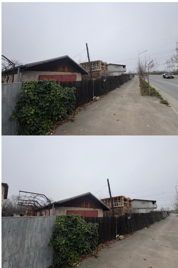
Vedere drum de acces lateral secundar:
