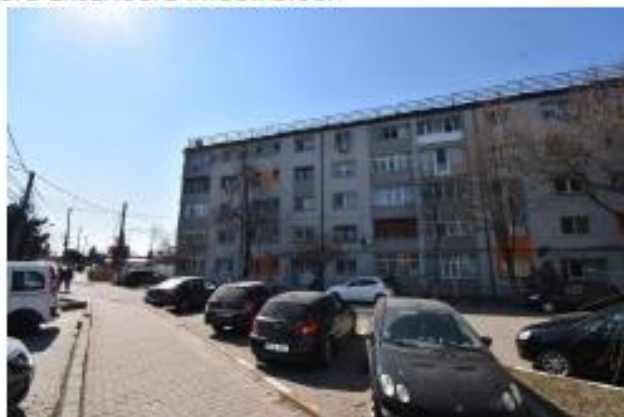
Vedere exterioară imobil bloc:
